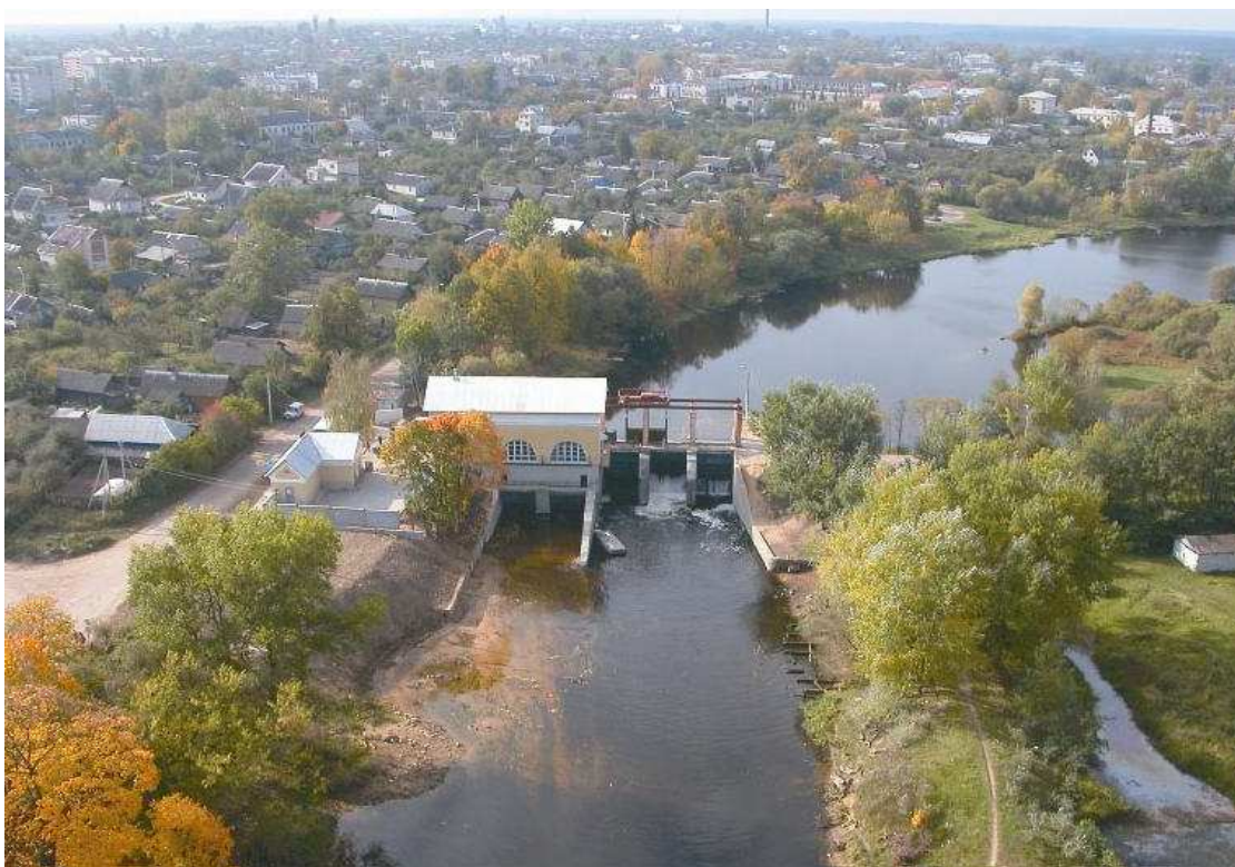
Малая гидроэлектростанция в Лепеле (Витебская область)
