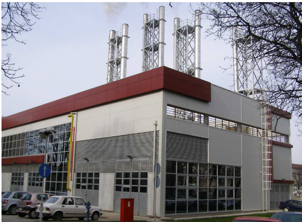
Когенерационная энергетическая установка в Клиническом Центре Сербии
