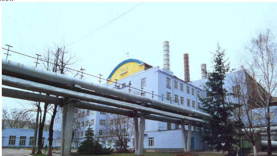
Харьковская комбинированная ТЭЦ (ТЭЦ-3)
