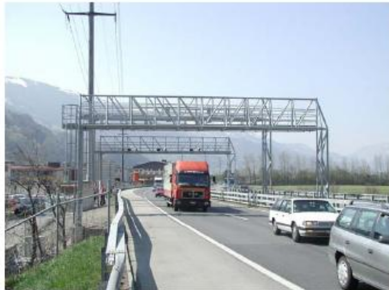
Kontrollanlage bei Bad Ragaz
