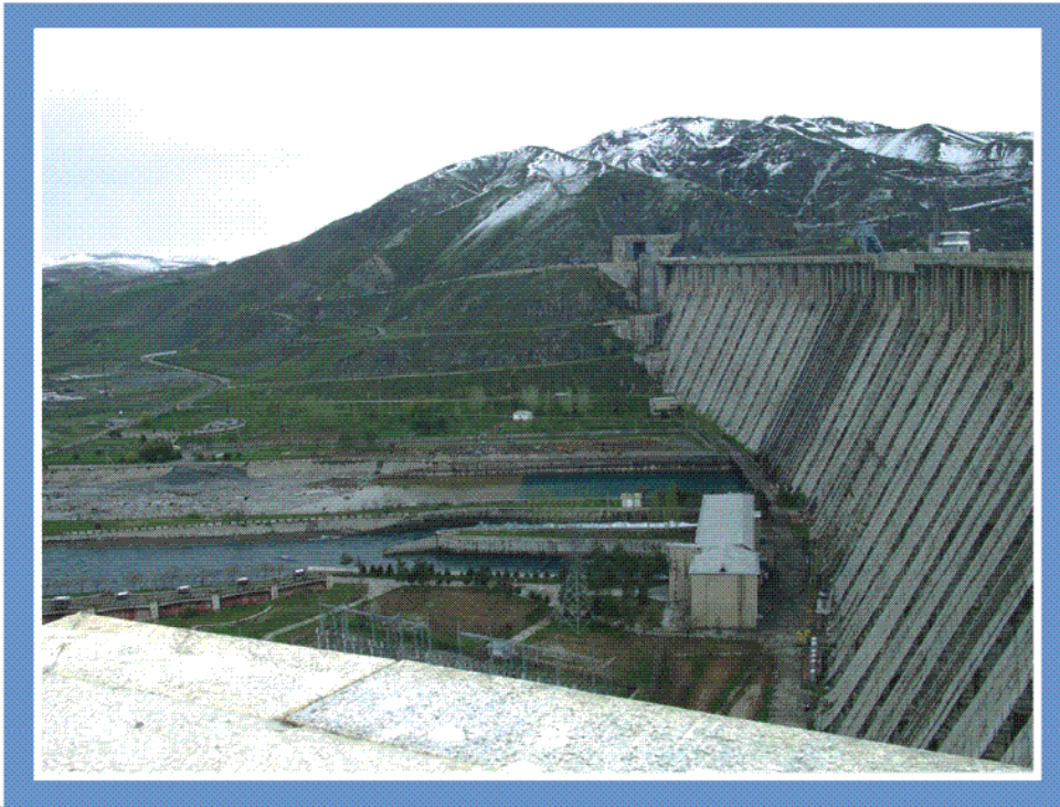
Рис. 16. Плотина Андижанского гидроузла на реке Карадарья, Узбекистан (высота плотины - 121 м; объем водохранилища - 1900 млн.м 3 )
