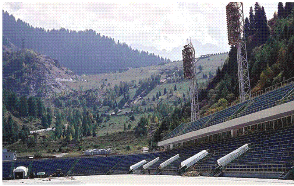
Рис. 4. Селезащитная плотина Медео на реке Малая Алматинка, Казахстан (высота плотины - 144 м; объем водохранилища - 12,6 млн.м 3 )
