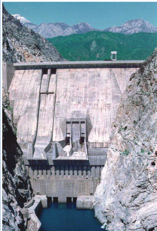
Рис. 7. Плотина Токтогульского гидроузла на реке Нарын, Казахстан (высота плотины - 215 м; объем водохранилища - 19500 млн.м 3 )
