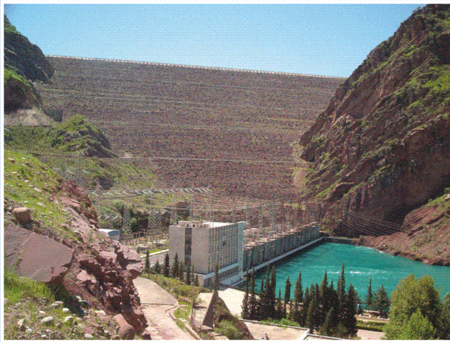
Рис. 10. Плотина Нурекского гидроузла на реке Вахш, Таджикистан (высота плотины - 300 м; объем водохранилища - 10500 млн.м 3 )
