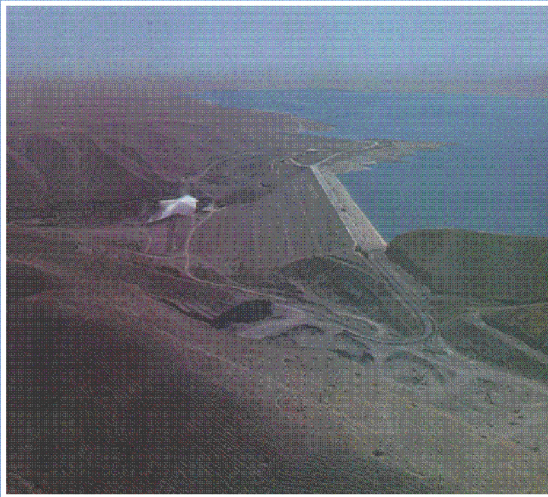
Рис. 18. Плотина Каркидонского гидроузла на реке Кувасай, Узбекистан (высота плотины - 70 м; объем водохранилища - 218,4 млн.м 3 )
