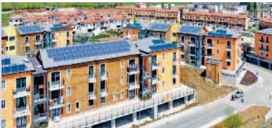
Рисунок 6 – Проект С.А.С.Е.: Многоэтажные дома в районе Претуро. Установка фотоэлектрических модулей в сочетании с панелями солнечных батарей, размещенных на южных скатах кровель 85 .
