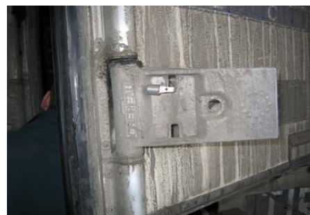
D. Poignée tournée, tringle de crémone activée: la porte est ouverte et le scellement reste intact.
