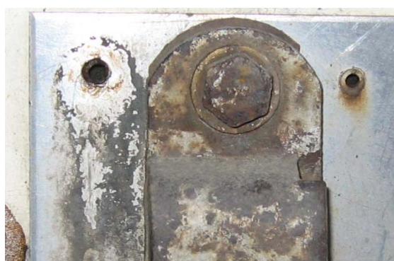
A. Les dispositifs originaux des tringles de crémone ont de toute évidence été remplacés.
