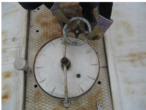
C. Boulon central enlevé et poignée dégagée de l'axe principal.
