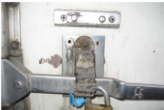
A. Les dispositifs originaux des tringles de crémone ont de toute évidence été remplacés.
