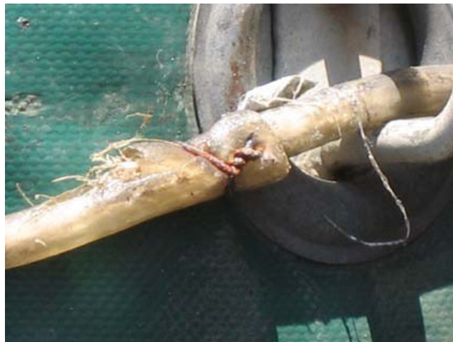
С: Трос МДП, соединенный кусочком проволоки: элементарно скрученный и без труда заменяемый.
