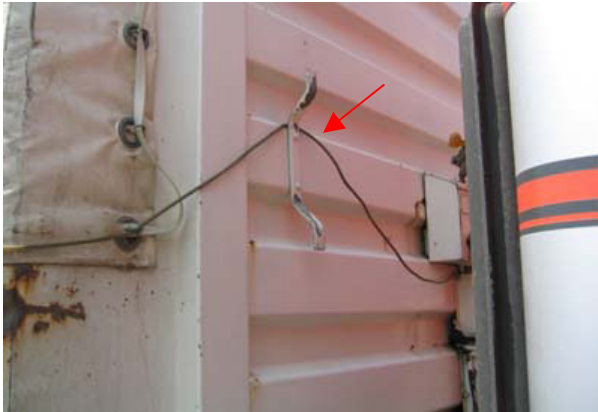
А: Трос МДП подвешен на крюк около кабельной коробки.
