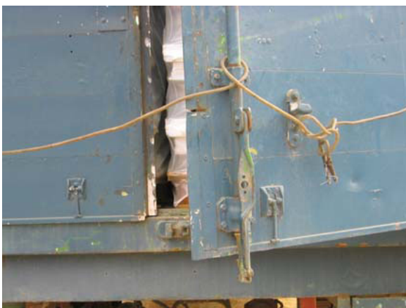
С: Слишком длинный трос МДП: ручка управления не закреплена. Трос даже не проходит через отверстие в поворотном устройстве и ручке.
