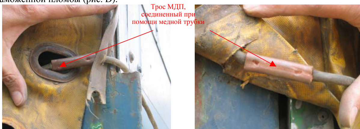
А: Перезанный или разорванный трос МДП, который отремонтирован при помощи кусочка медной трубки.
