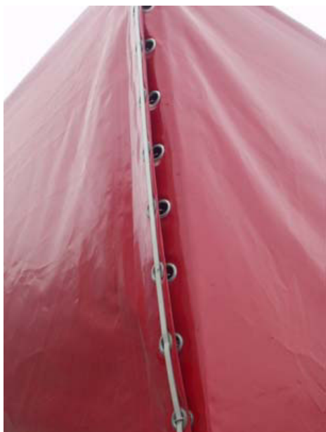
В: Легко открывающееся перекрытие брезента оставляет отверстие размером 150 см.
