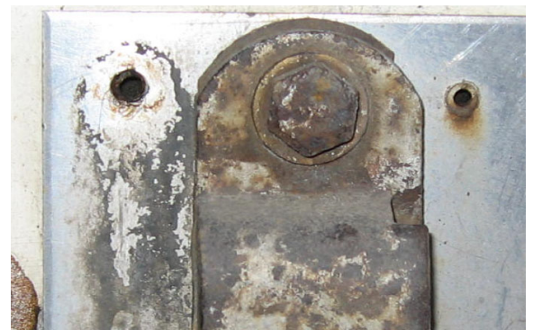
А: Первоначальные устройства, предназначенные для всех запирающих стержней, несомненно, заменены.
