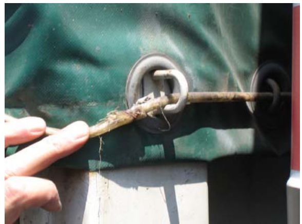
В: Под снятой лентой обнаружено соединение троса МДП.
