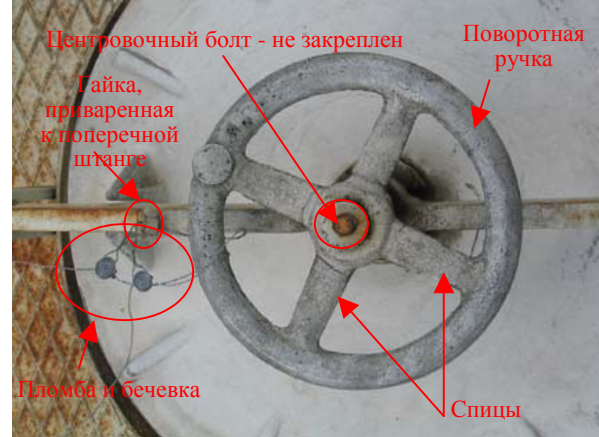
В: Опечатывающее устройство: гайка, приваренная к поперечной штанге, бечевка для наложения пломбы, проходящая непосредственно через гайку, и пространство между спицами поворотной ручки.
