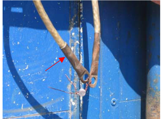
В: Наконечник, изготовленный из медной трубки, которая элементарно обжата вокруг троса. Легко снимаются и вновь устанавливаются.
