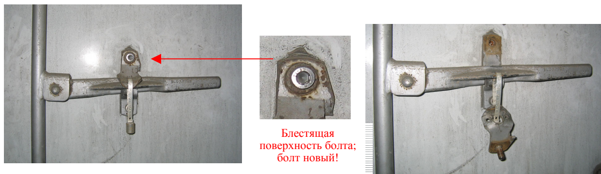
А: Все поворотные устройства, по-видимому, являются первоначальными.
