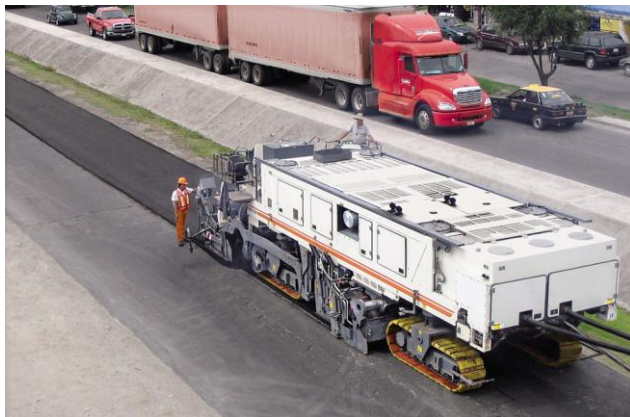
Kaltrecycler im Einsatz
