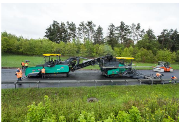
Beschicker, Asphaltfertiger und Gummiradwalze im Einsatz
