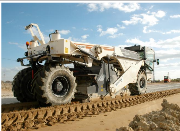
Kaltrecycler / Bodenstabilisierer im Einsatz
