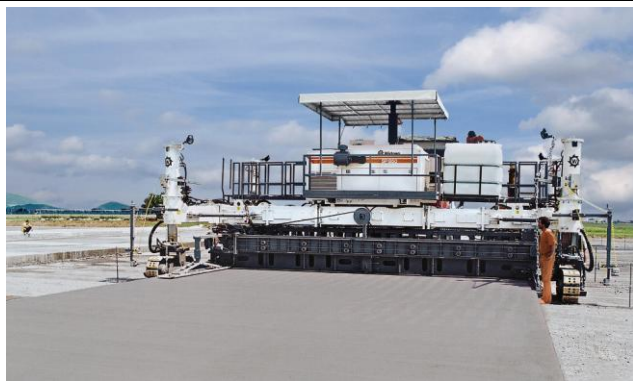
Gleitschalungsfertiger im Einsatz
