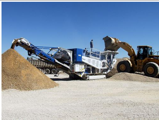
Mobiler Brecher im Einsatz
