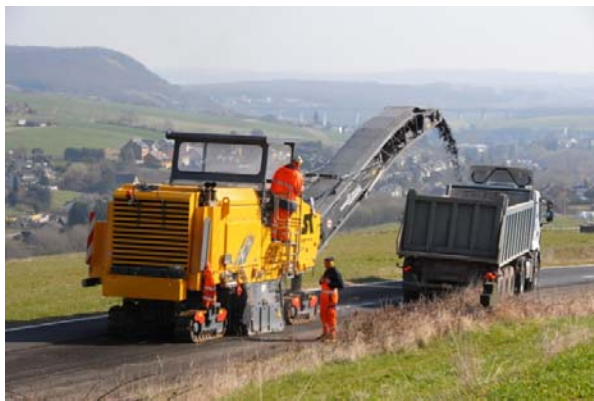
Grande fraiseuse routière en action
