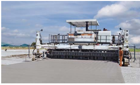
Machine à coffrages glissants en action
