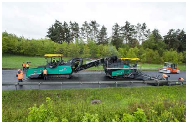
Alimentateur, asphalteuse et rouleau à pneus en action
