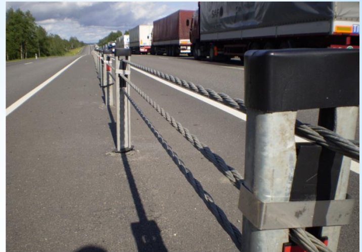
Тросовое ограждение для разделения транспортных потоков встречных направлений.
