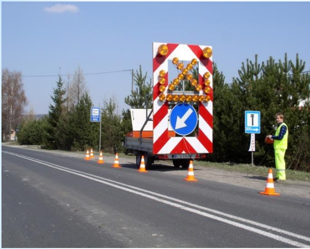
Обустройство мест производства дорожных работ
