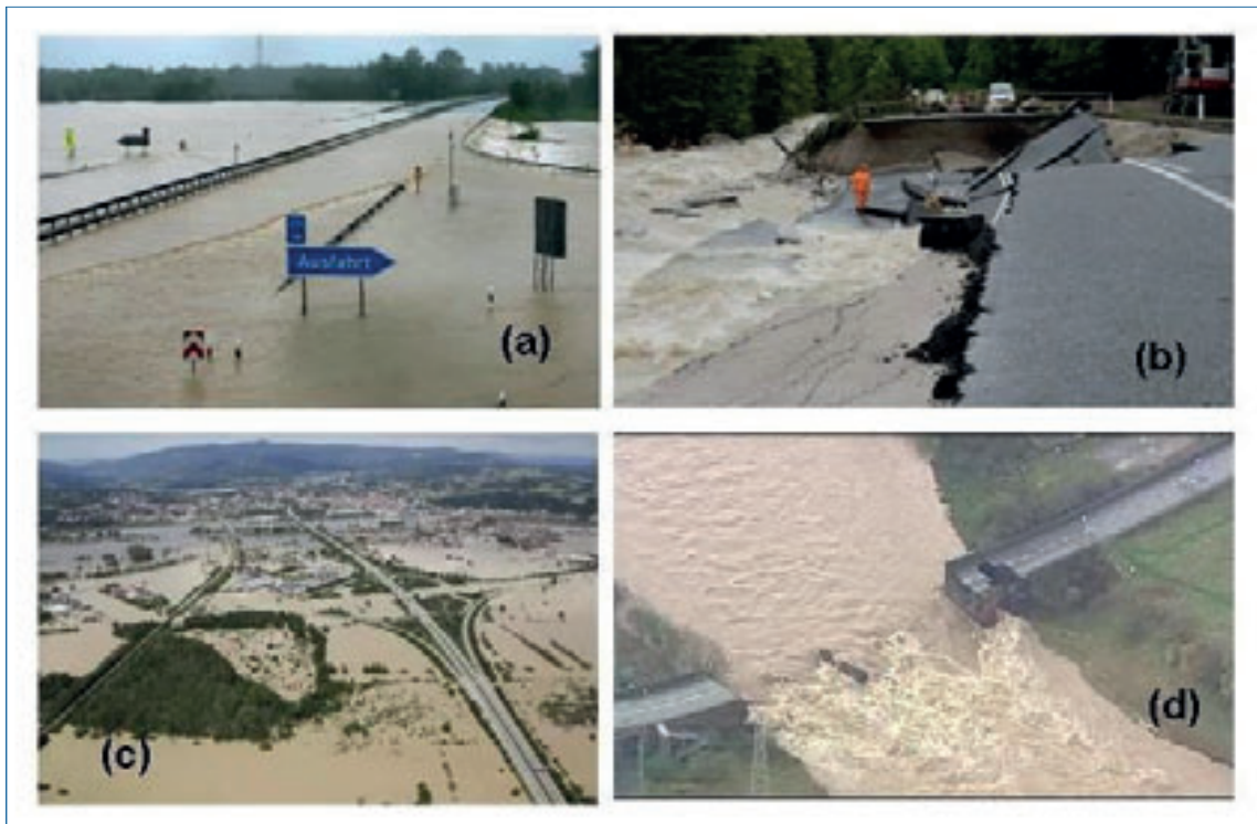
Рисунок 26. Ущерб, причиняемый автодорогам при паводках: а) автомагистраль № 8 (Мюнхен – Зальцбург) в Грабенштетте вблизи Траунштайна (южная Германия) (начало июня 2013 года, Маттиас Шрадер, АП); б) сильные повреждения дороги между Лофером и Вайдрингом в Тироле (Австрия) (3 июня 2013 года, Керстин Йонссон, АП); в) затопленное шоссе в Деггендорфе; и д) обрушение моста в Кумбрии (Соединенное Королевство Великобритании и Северной Ирландии) в ноябре 2009 года ( http://news.bbc.co.uk/2/hi/uk_news/8369934.stm ).
