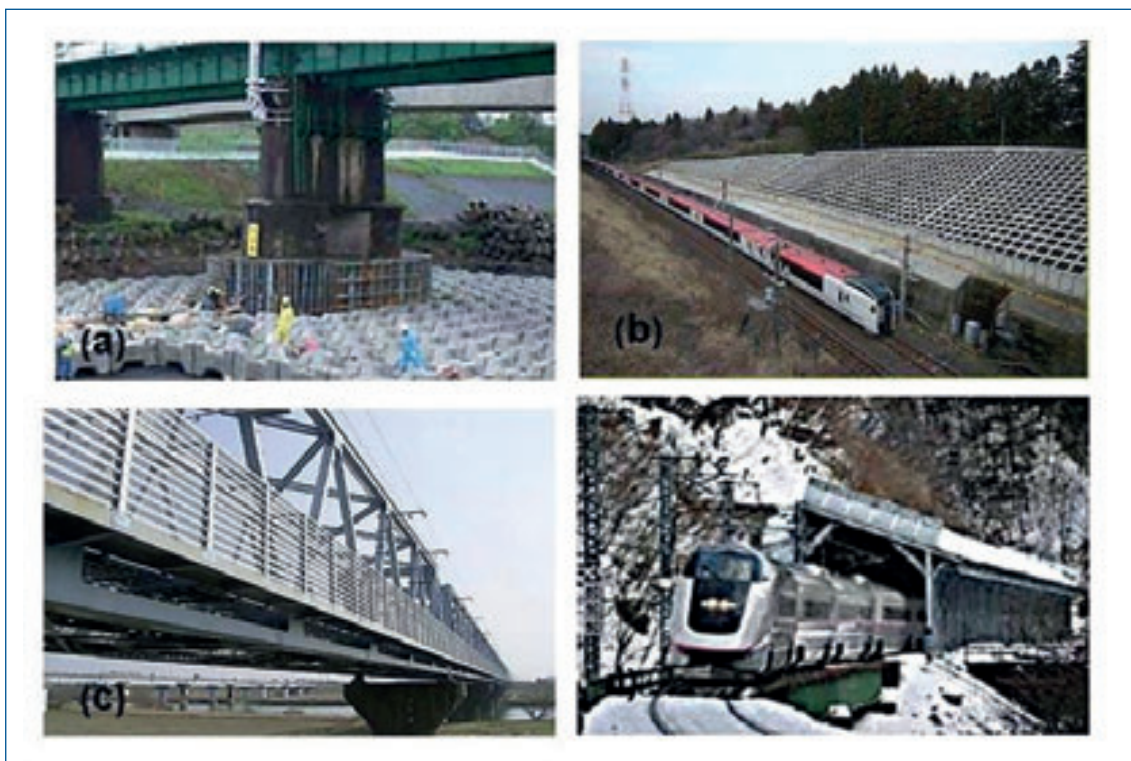
Рисунок 56. а) Защита от размыва опор, б) укрепление склонов, в) ветрозащитные ограждения/экраны и г) противолавинные сооружения .
