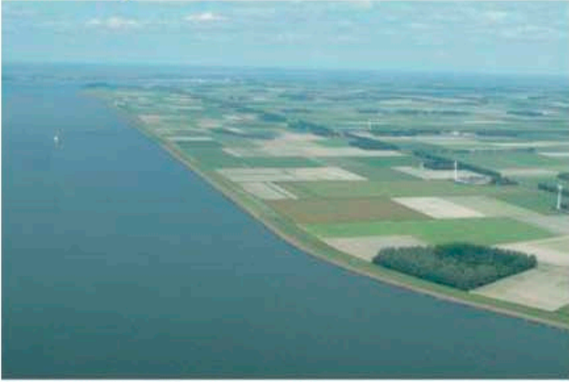
Westermeerdijk met bestaande opstelling
