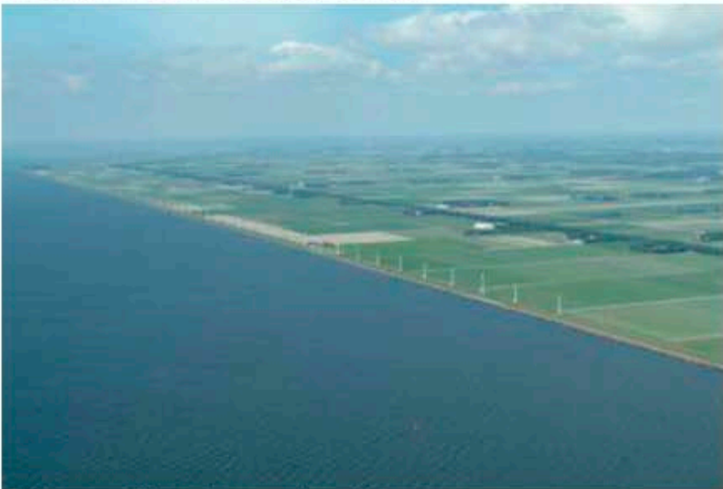
Zuidermeerdijk met bestaande turbines
