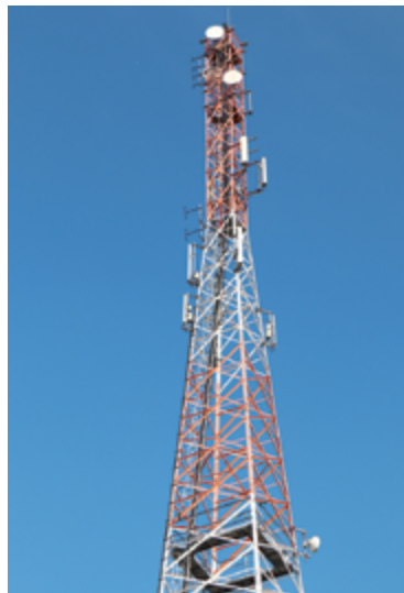
Башня связи у поселка Анненский мост на реке Ковжа (Волго-Балтийский водный путь, Российская Федерация).
