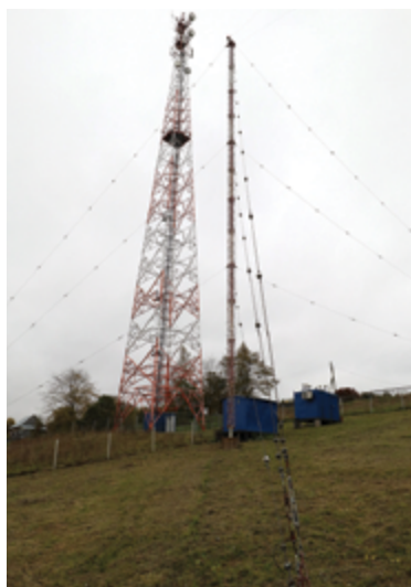
Башня связи и контрольно-корректирующая станция ГНСС у поселка Иванов Бор на реке Шексна (Российская Федерация).
